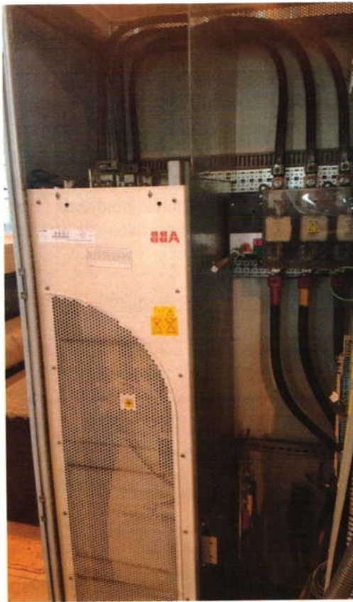
2. ábra Az ABB frekvenciaváltó
