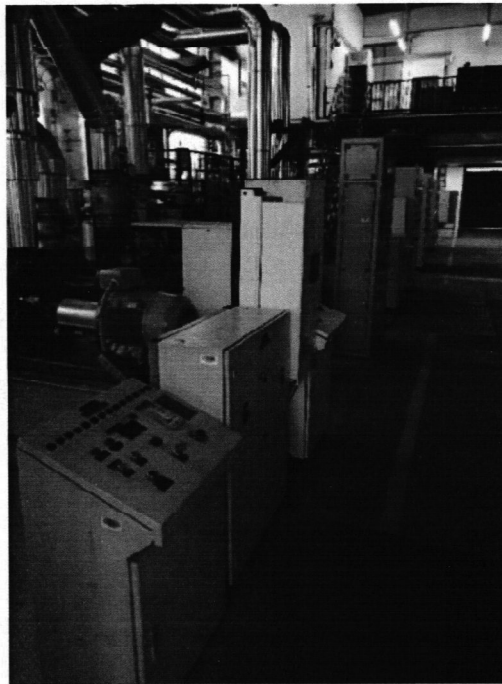
9. ábra – K4 kazánvezérlő pult és működtető szekrény, melynek helyére kell telepíteni a kazáncsarnoki megjelenítőket
